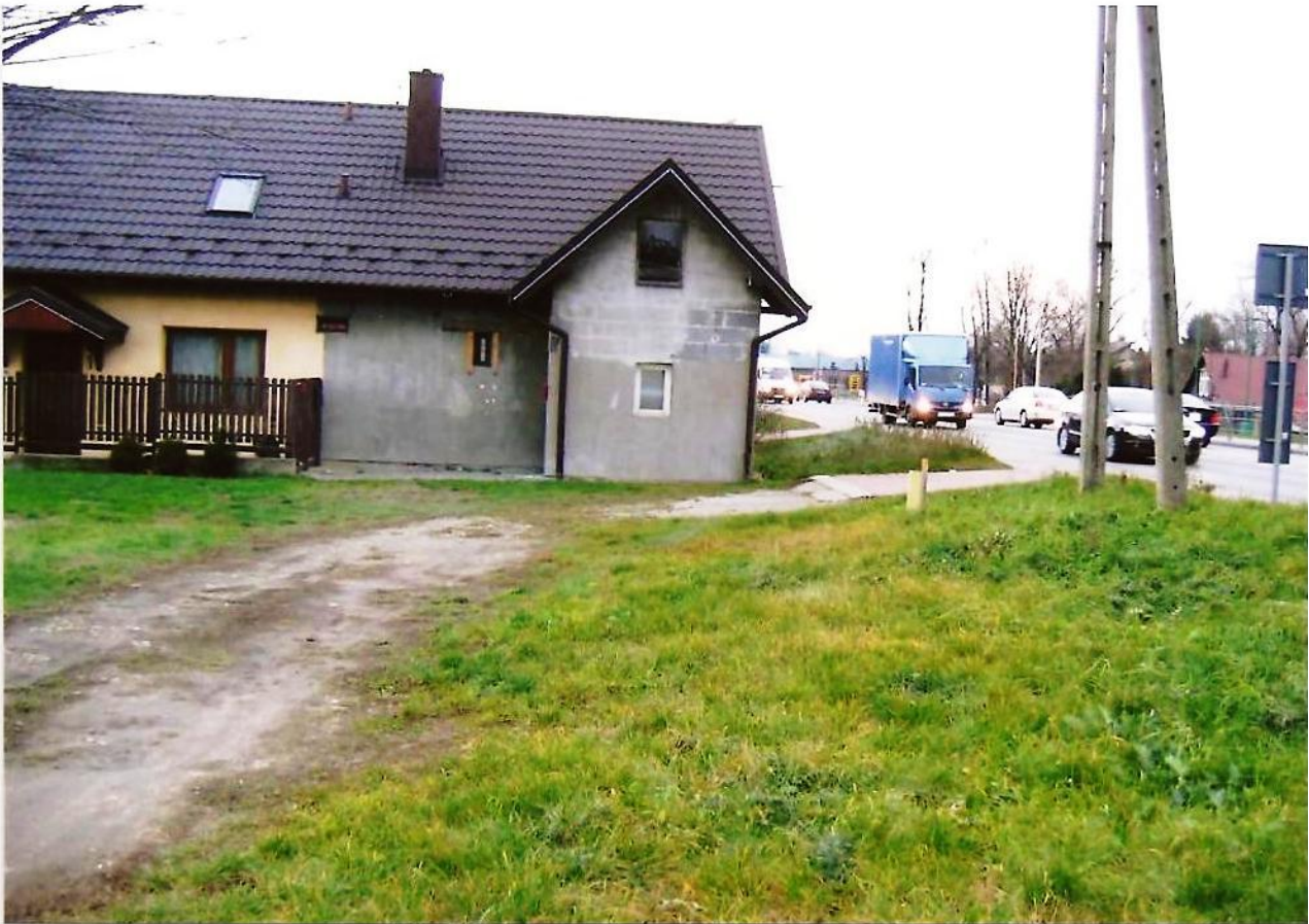
Rys. 1. Na wprost, zabudowana szarym segmentem, działka nr 1932/2, widok od strony zachodniej. Po prawej stronie widoczna droga krajowa nr 4.
