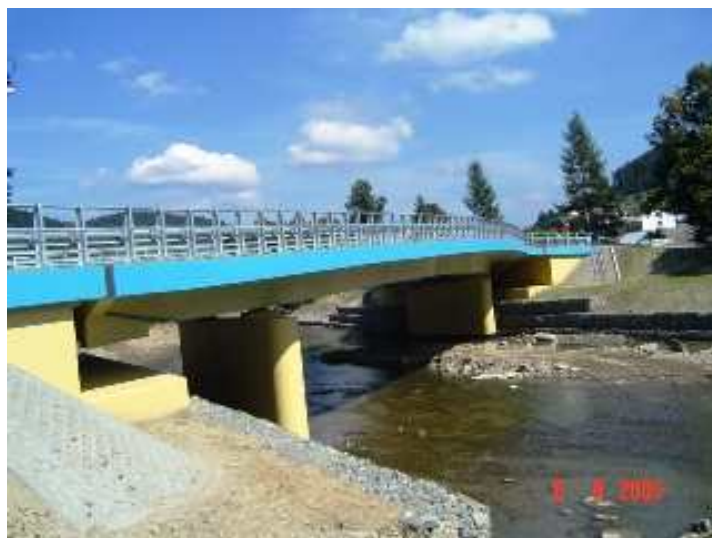
Most na Muszynce po zakończeniu inwestycji
