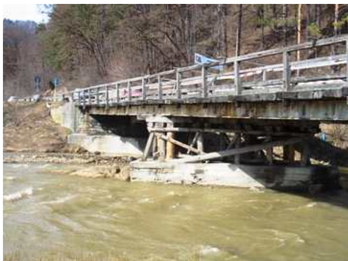
Most na Muszynce przed rozpoczęciem inwestycji
