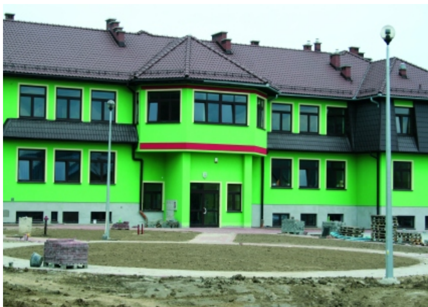
Budynek gimnazjum w Tęgoborzy, gmina Łososina Dolna
