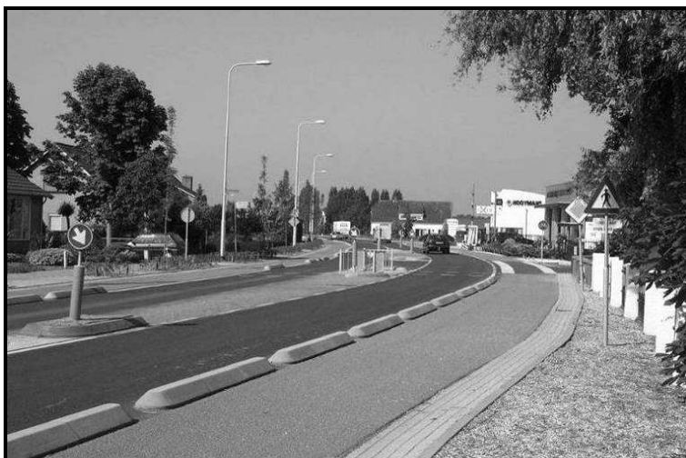
Fot. 5. Przykład strefy ruchu uspokojonego o dopuszczalnej prędkości 50 km/h (Holandia) - droga opowiadająca drodze krajowej w przejściu przez miejscowość
