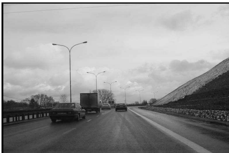
Fot. 9. Przykład wału ziemnego chroniącego zabudowę przed oddziaływaniem hałasu (odcinek drogi krajowej nr 4 Kraków - Tarnów)
