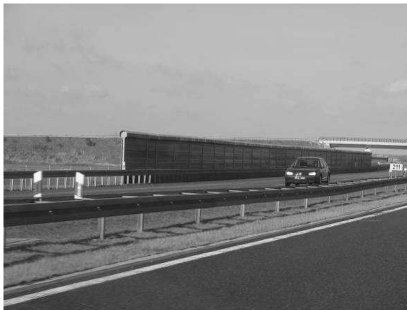
Fot. 8. Przykład typowego zastosowania ekranu akustycznego na autostradzie A4
