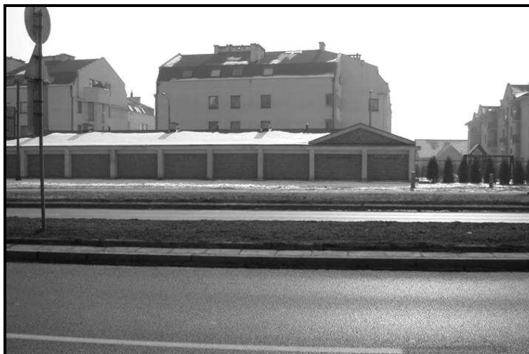
Fot. 11. Ekranowanie obiektów mieszkalnych przez garaże usytuowane bezpośrednio przy ulicy (Polska)
